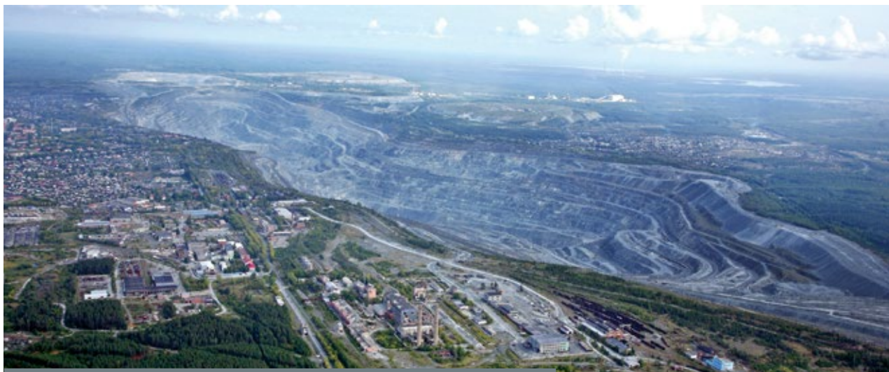
Карьер Баженовского месторождения хризотил-асбеста, ПАО «Ураласбест»
