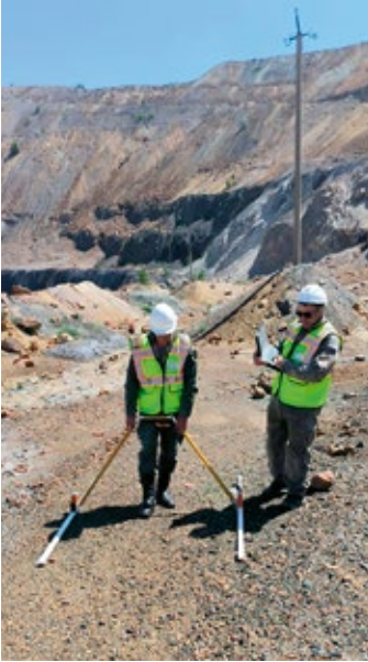
Рис. 1. Обследование дамбы хвостохранилища ПО «Жезказганцетмет» моноимпульсным георадаром резидента «Сколково»
