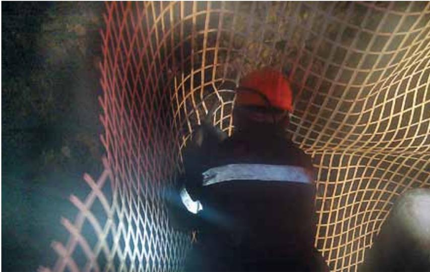
которых состоит из десяти проволок. Конструкция получается легкой, можно сказать, ажурной. Но, несмотря на кажущуюся «воздушность», сетка «ТехПолимера» способна выдерживать разрывные нагрузки до 103,3 кН/м и отлично себя чувствует даже при очень низких температурах — до минус 55 °С.
