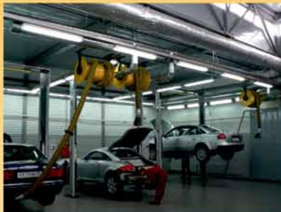
**Система удаления выхлопных газов. Вытяжная катушка**
