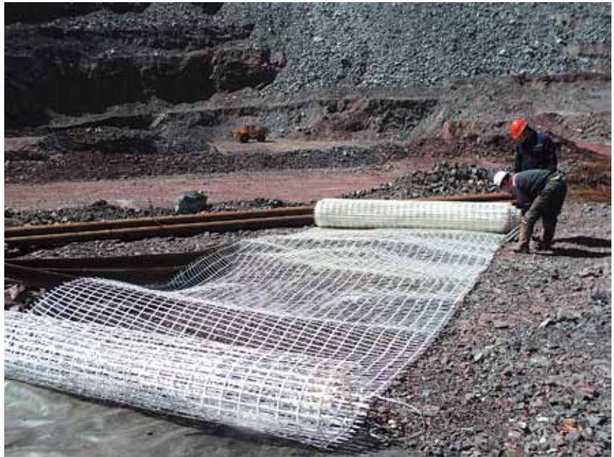
вержен коррозии. Достичь такого уровня устойчивости помогает особая двухслойная «структура» сетки. Она изготавливается из стальной пружинной углеродистой проволоки диаметром 0,6 миллиметра — в соответствии с ГОСТ 9389-75. А затем покрывается поливинилхлоридом (ГОСТ 5960).
